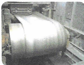
Före installation av Tru-Trac
