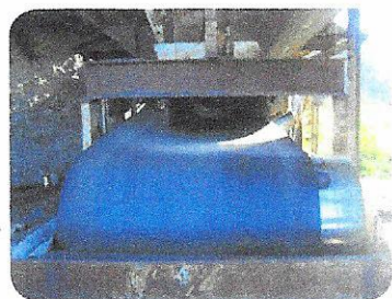
Före installation av Tru-Trac
